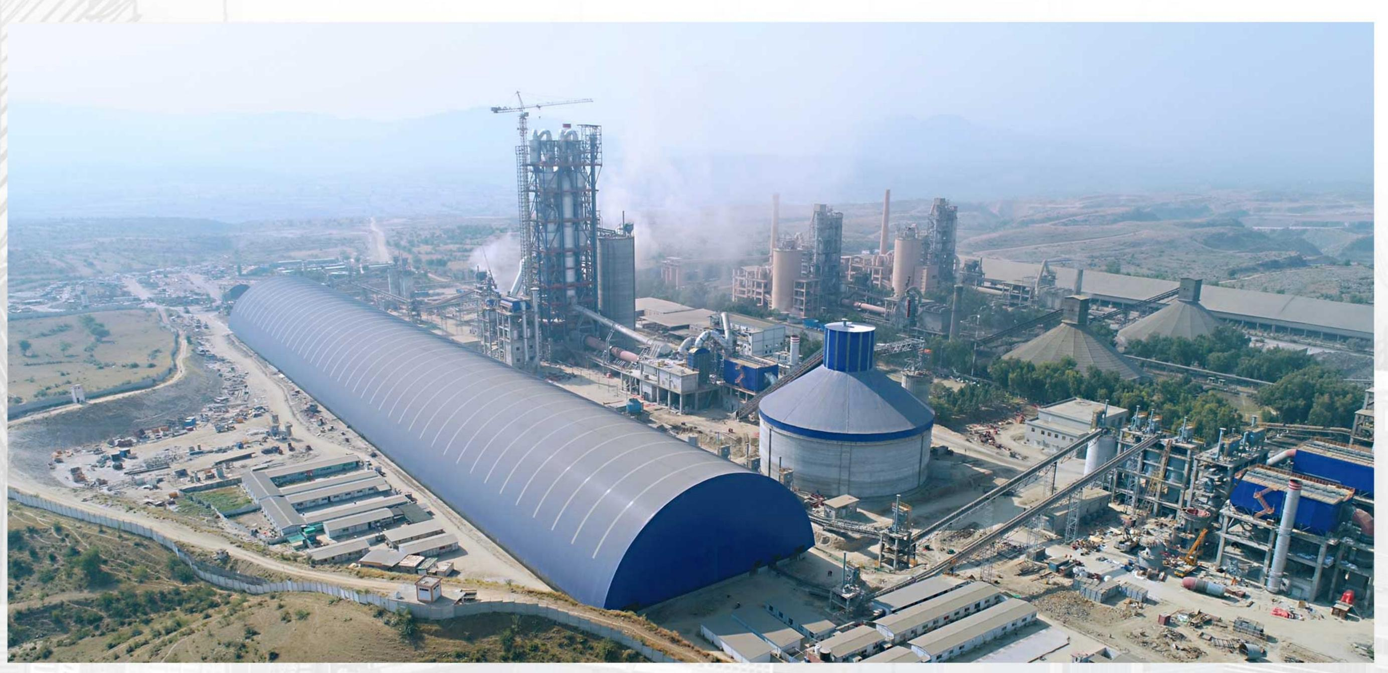
巴基斯坦Askari日产6500吨熟料生产线及余热发电项目 6500t/d Cement Line with Waste Heat Recovery System at Askari Cement Pakistan Ltd.
